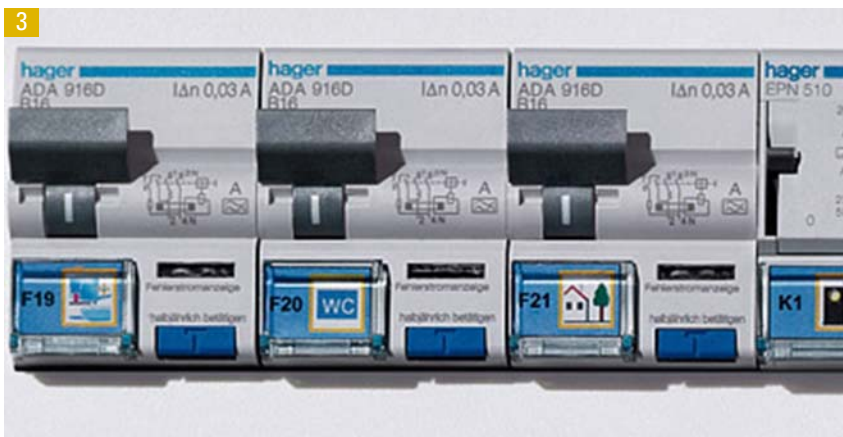
Fehlerstrom-Schutzeinrichtungen.
