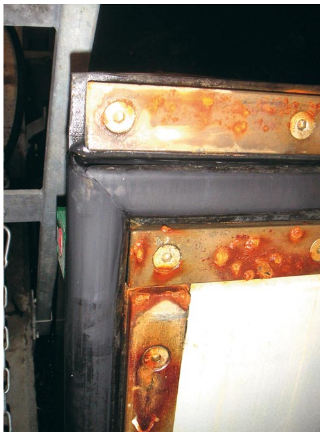
Bild 5 Korrosion an einem Segmentschütz mit starker Pustelbildung.
