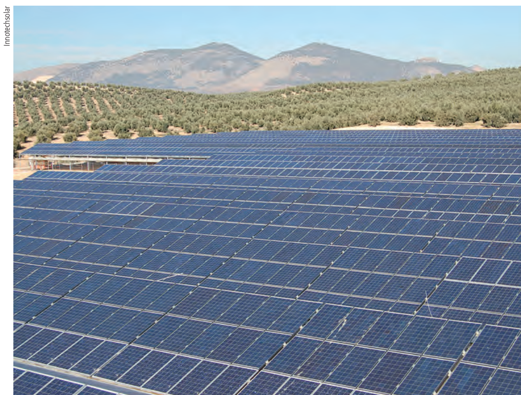
4,3-MW-Fotovoltaikanlage bei Granada, Spanien. Die Anbindung von Fotovoltaikanlagen an bestehende Netze ist anspruchsvoll.
